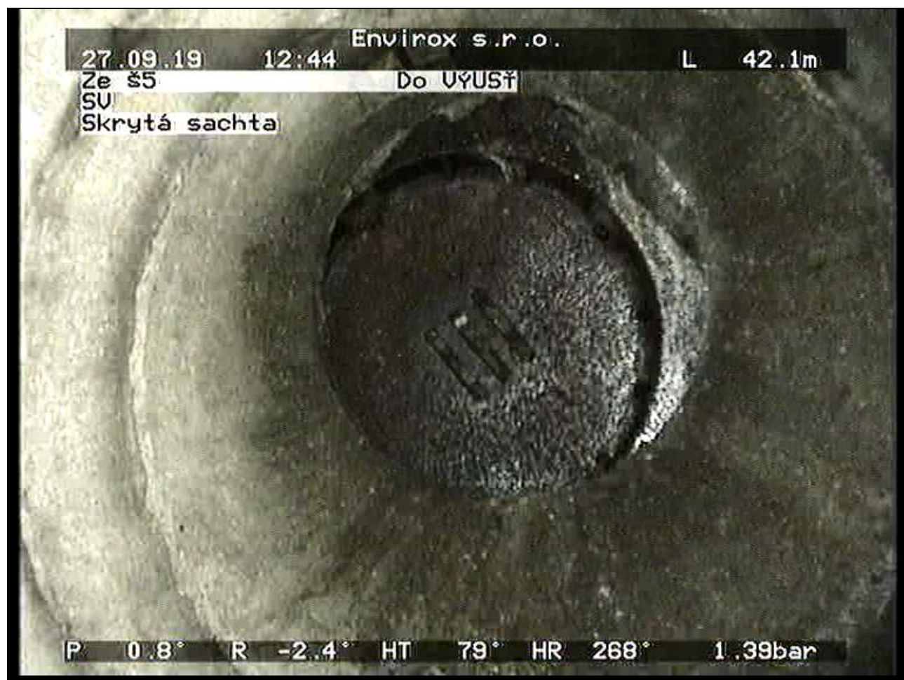
Obr. č. 5 – skrytá šachta, pohled vzhůru (foto Envirox s.r.o.)
