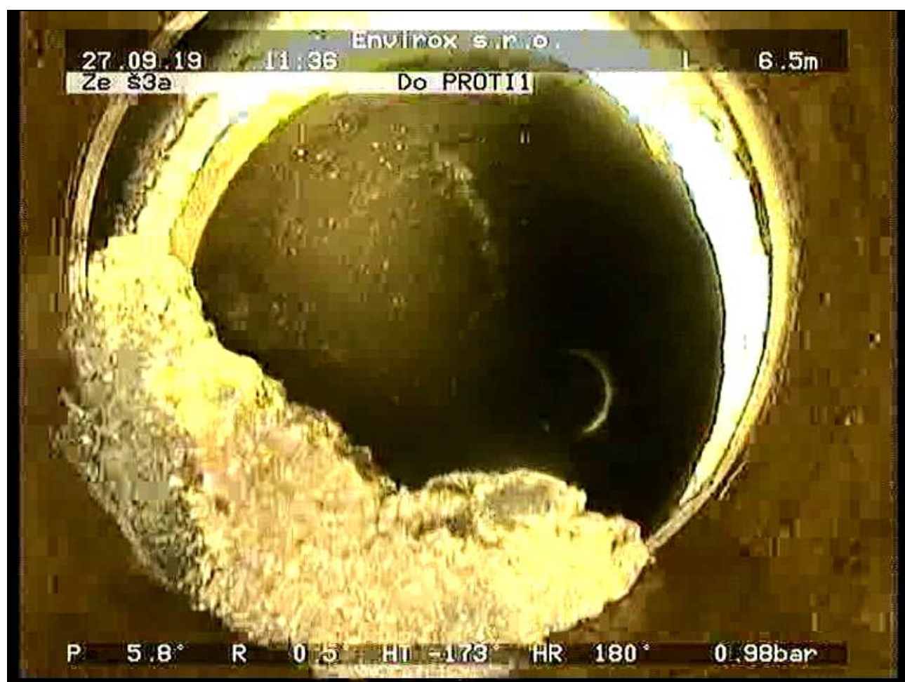
Obr. č. 8 – inkrustace ve stoce vedoucí ze šachty Š3a směrem na jihovýchod, směrem ke kolejišti. (foto Envirox s.r.o.)
